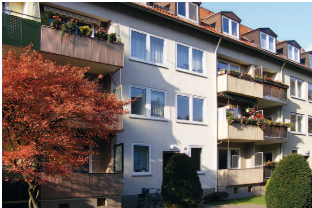
Die Mieter am Graswege 12 können sich auf neue Loggien, ein neues Dach und neu gestaltete Außenanlagen freuen.
