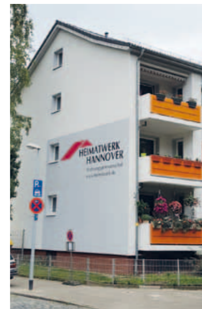
Unter dem Dachüberstand wurden 46 Nistkästen für Mauersegler installiert.
