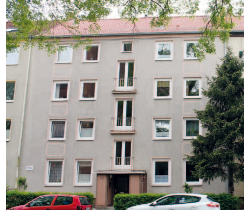
Neue Optik und Energieeffizienz: Die Marschnerstraße erhält eine neue Dämmung, außerdem werden die Hauseingangstüren ausgetauscht.
