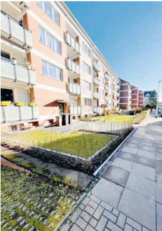
An der Suthwiesenstraße in Hannover-Döhren wurden Vorgarten und Garten erneuert.
