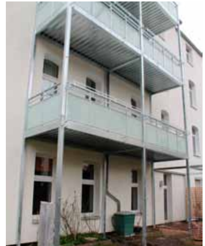
Endlich fertig: Die vier neuen Balkone an der Jacobsstraße 15.
