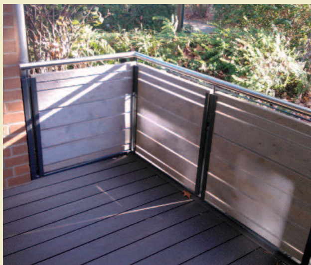
Terrassenerneuerung im Haus an der Feldstraße 6
