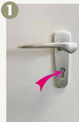
1 Um dieses Teil in der Türarmatur geht es.
