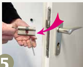
So sehen Schraube und Schließzylinder aus.
