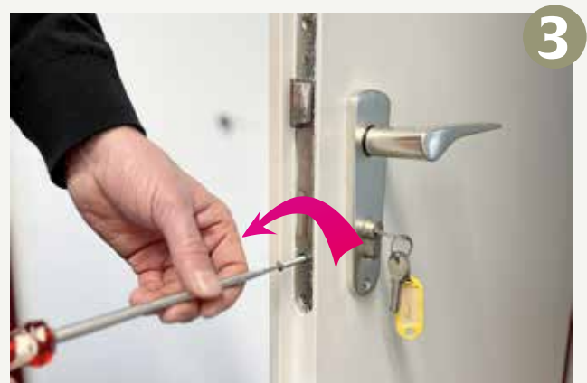
3 Drehen Sie die Schraube mit einem Schraubendreher komplett heraus. Hinweis: Die Schraube ist lang, Sie müssen also eine ganze Weile drehen! Ziehen Sie die Schraube dann ganz hinaus.
