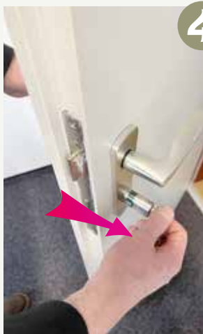
Nun können Sie den Schließzylinder mit Hilfe des dazugehörigen Schlüssels herausziehen. Verdrehen Sie den Schlüssel
