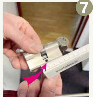
Sie sollten den Schließzylinder also zunächst ausbauen und die Abstände zum Schraubloch in der Mitte messen. Mit diesen Maßen besorgen Sie dann einen neuen Zylinder. Diesen bauen Sie in umgekehrter Reihenfolge wieder ein.
