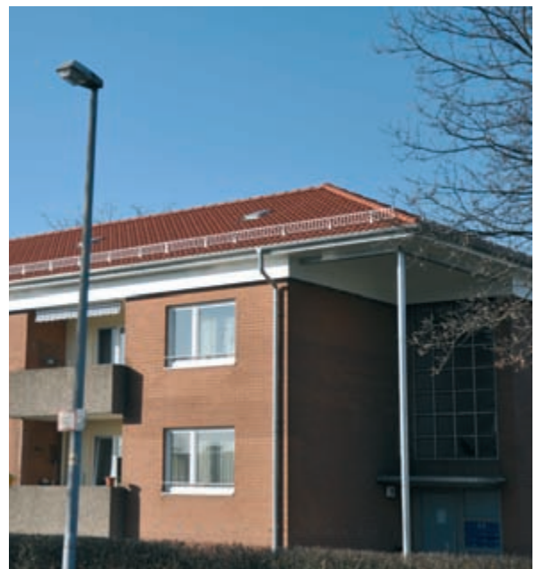
Ahornstraße 9 nach dem Umbau
